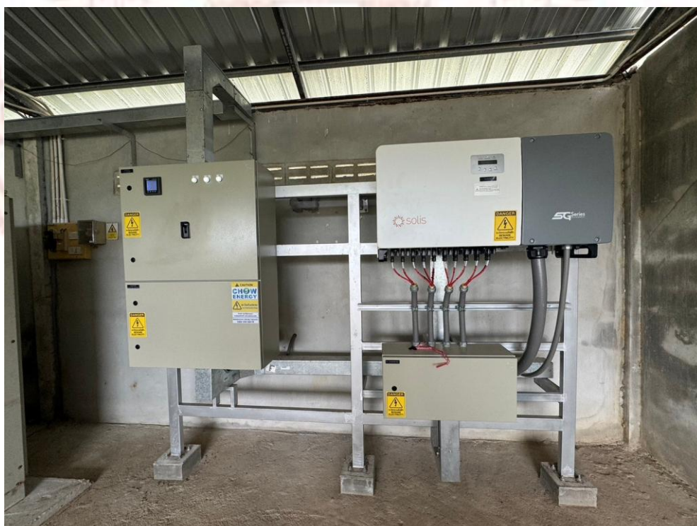
ภาพที่ 3-4: งานติดตั้งห้องอินเวอร์เตอร์ ฟาร์ม A
