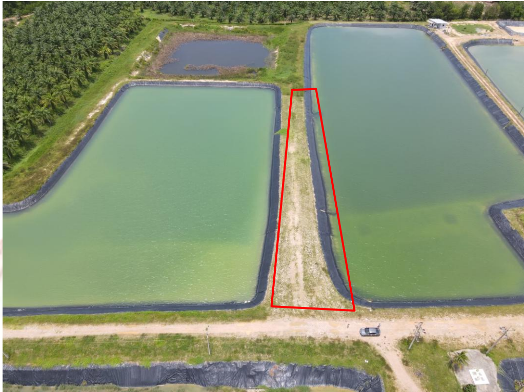
ภาพที่ 3-11: บริเวณที่จะติดตั้งระบบผลิตไฟฟ้าพลังงานแสงอาทิตย์ ฟาร์ม C
