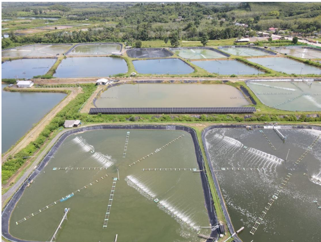
ภาพที่ 3-3: งานติดตั้งระบบผลิตไฟฟ้าพลังงานแสงอาทิตย์ฟาร์ม A
