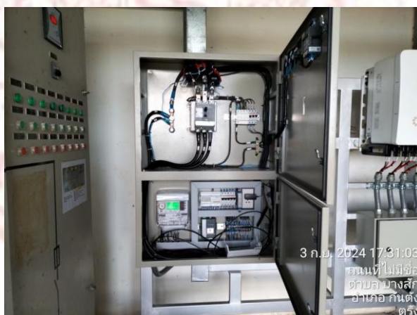
ภาพที่ 2-13: การดำเนินโครงการ ขั้นตอนการดับไฟเชื่อมต่อบระบบ
