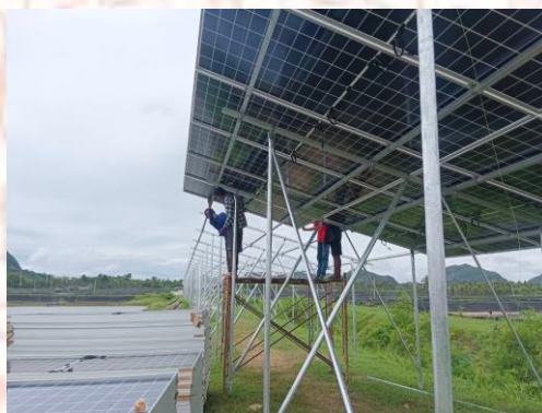
ภาพที่ 2-12: การดำเนินโครงการ ขั้นตอนการติดตั้งแผงโซลาร์เซลล์
