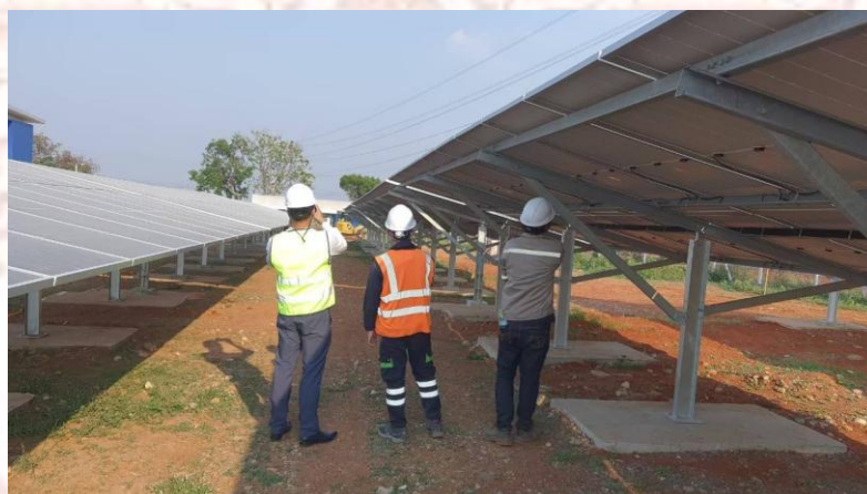
ภาพที่ 2-5: การติดตั้งบนพื้นดินโดยใช้รากฐานเป็นคอนกรีตเสริมเหล็ก
