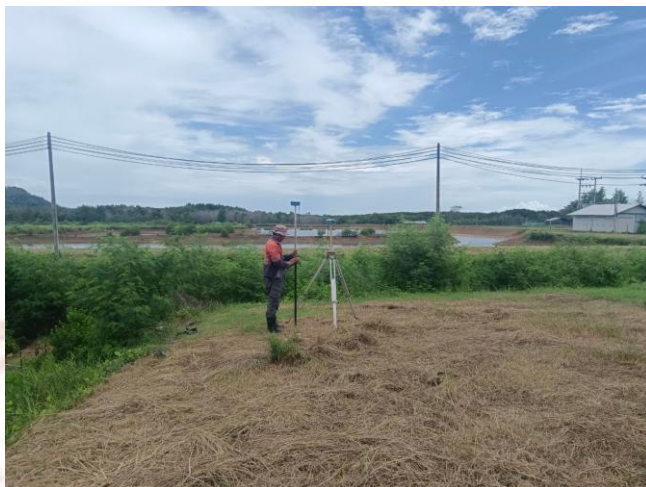
ภาพที่ 2-11: การดำเนินโครงการ ขั้นตอนสำรวจ Topographic Map ก่อนเริ่มติดตั้งโครงสร้าง
