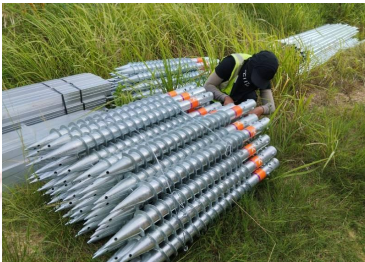
ภาพที่ 2-6: รากฐานเสาเข็มเหล็ก
