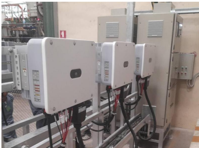
ภาพที่ 2-2: อุปกรณ์อินเวอร์เตอร์ (Inverter)
