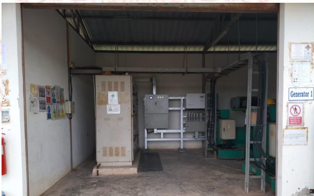
ภาพที่ 3-8: งานติดตั้งห้องอินเวอร์เตอร์ ฟาร์ม B
