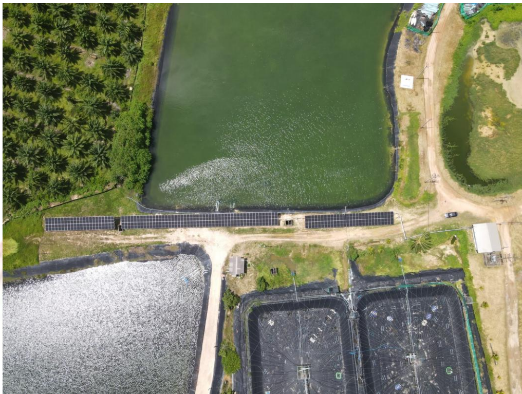
ภาพที่ 3-7: งานติดตั้งระบบผลิตไฟฟ้าพลังงานแสงอาทิตย์ฟาร์ม B
