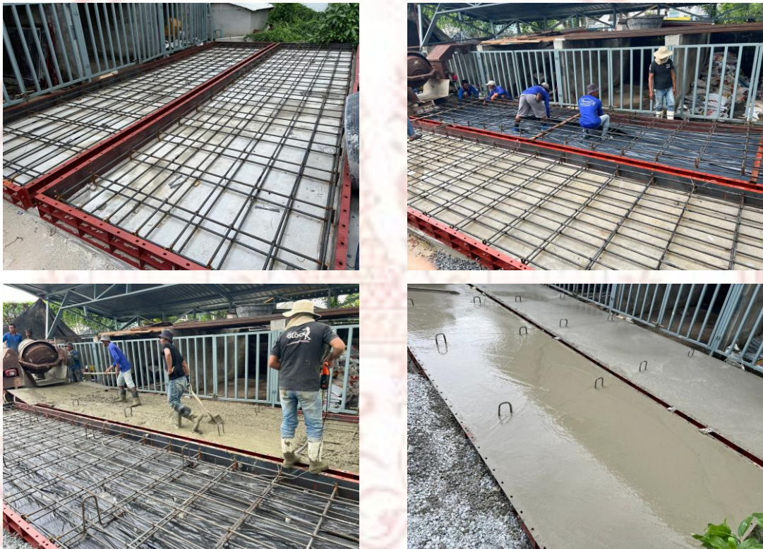
รูปที่ 3.2-3 การก่อสร้างพื้นสะพานจำลอง
