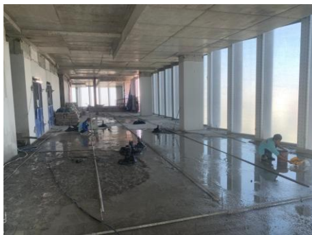
ภาพที่ 3-6 ตัวอย่างงานเทคอนกรีตพื้นปรับระดับ
