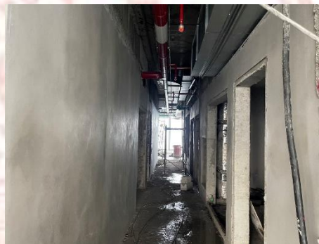
ภาพที่ 4-5 แสดงขั้นตอนการดำเนินงานฉาบผนังทางเดินส่วนกลาง (20)
