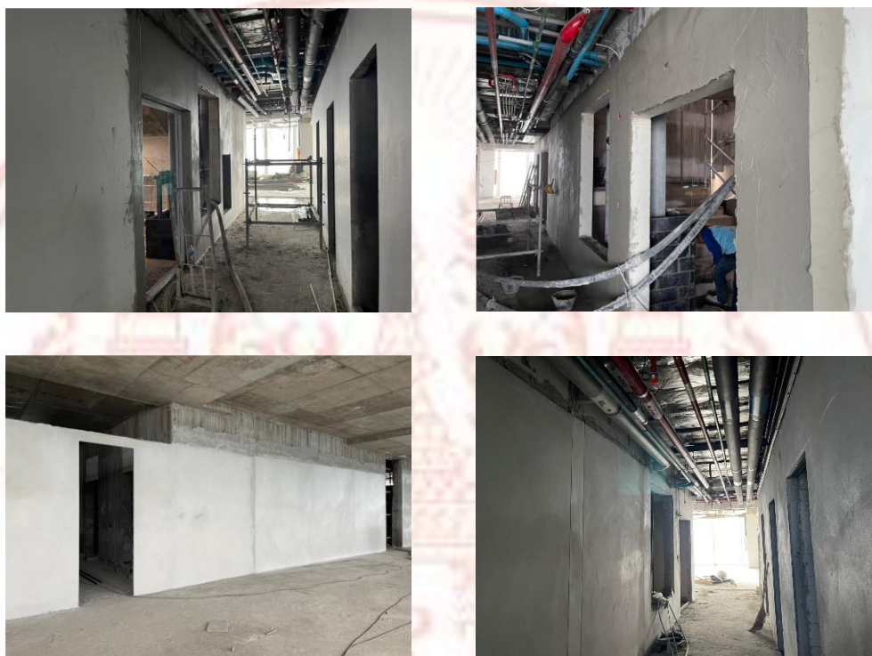
ภาพที่ 3-5 ตัวอย่างงานฉาบผนังทางเดินส่วนกลาง
