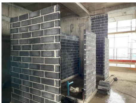
ภาพที่ 4-4 แสดงขั้นตอนการดำเนินงานก่ออิฐห้องน้ำ (15)
