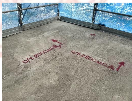
ภาพที่ 4-3 แสดงขั้นตอนการดำเนินงานตีไลน์ (5)
