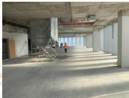
ภาพที่ 3-6 ตัวอย่างงานเทคอนกรีตพื้นปรับระดับ
