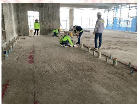
ภาพที่ 4-3 แสดงขั้นตอนการดำเนินงานตีไลน์ (5)
