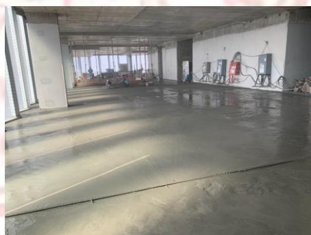
ภาพที่ 4-6 แสดงขั้นตอนการดำเนินงานคอนกรีตเทพื้นปรับระดับ (25)
