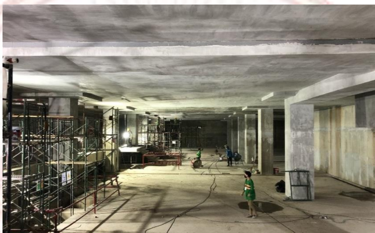
ภาพที่ 3-2 การสำรวจพื้นที่หน้างาน
