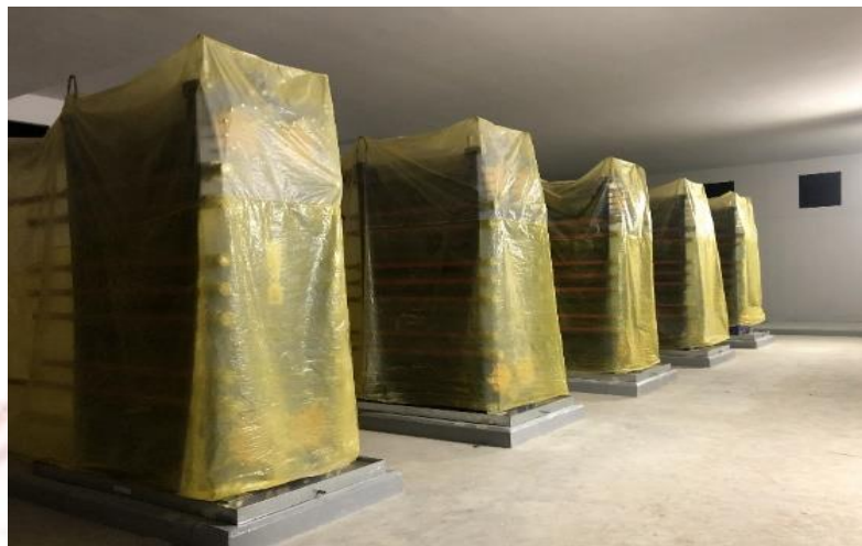
ภาพที่ 3-5 การติดตั้งเครื่องแลกเปลี่ยนความร้อน
