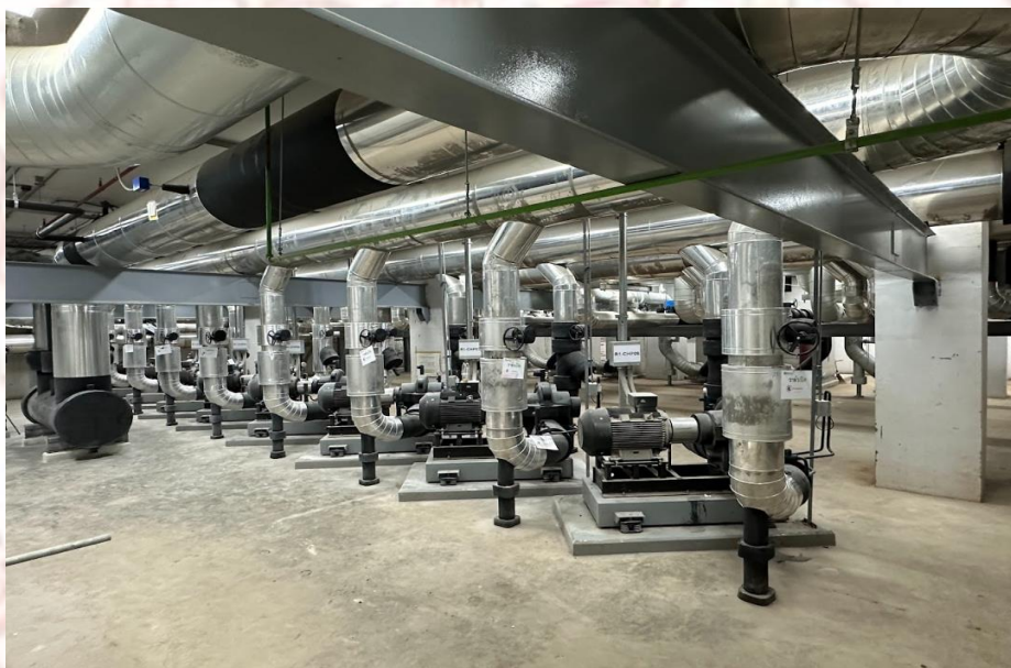
ภาพที่ 4-15 ห้องสถานีถ่ายโอนพลังงานรอกการทดสอบและส่งมอบงาน อาคารที่ 2
