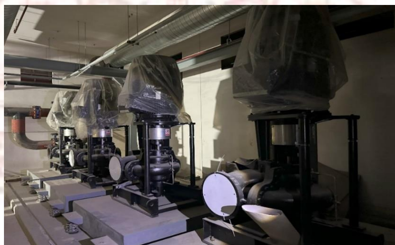
ภาพที่ 3-6 การติดตั้งเครื่องสูบน้ำ
