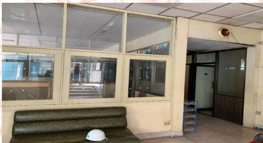
รูปที่ 3-5 ห้องคลีนรูมเดิมก่อนดำเนินการปรับปรุง
