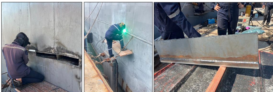
ภาพที่ 4-51 กระบวนการเชื่อมซ่อมโครงสร้างเรือ (ก) การเตรียมพื้นผิวและแนวเชื่อมก่อนการเชื่อมจริง (ข) กระบวนการเชื่อมในแนวตั้ง (Vertical Position) (ค) ชิ้นงานเชื่อมที่ตัดออกมาเชื่อมซ่อม
