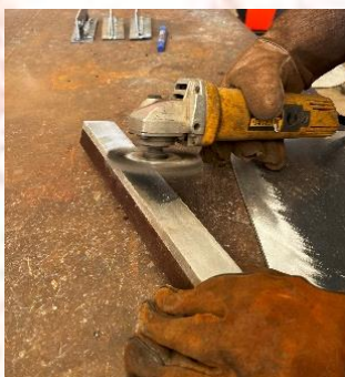
ภาพที่ 3-3 การเตรียมพื้นผิวด้วยการขัดด้วยเครื่องเจียร
