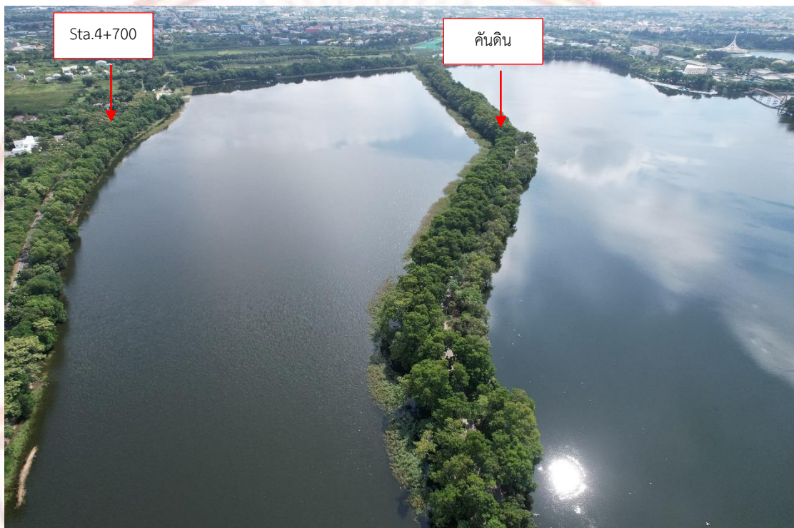
ภาพที่ 3-6 คันดินภายในบึงหนองบอนบริเวณ Sta.4+700
