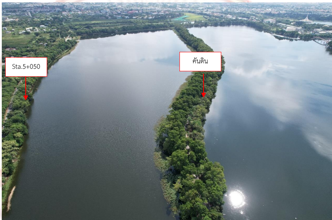
ภาพที่ 3-8 คันดินภายในบึงหนองบอนบริเวณ Sta.5+050
