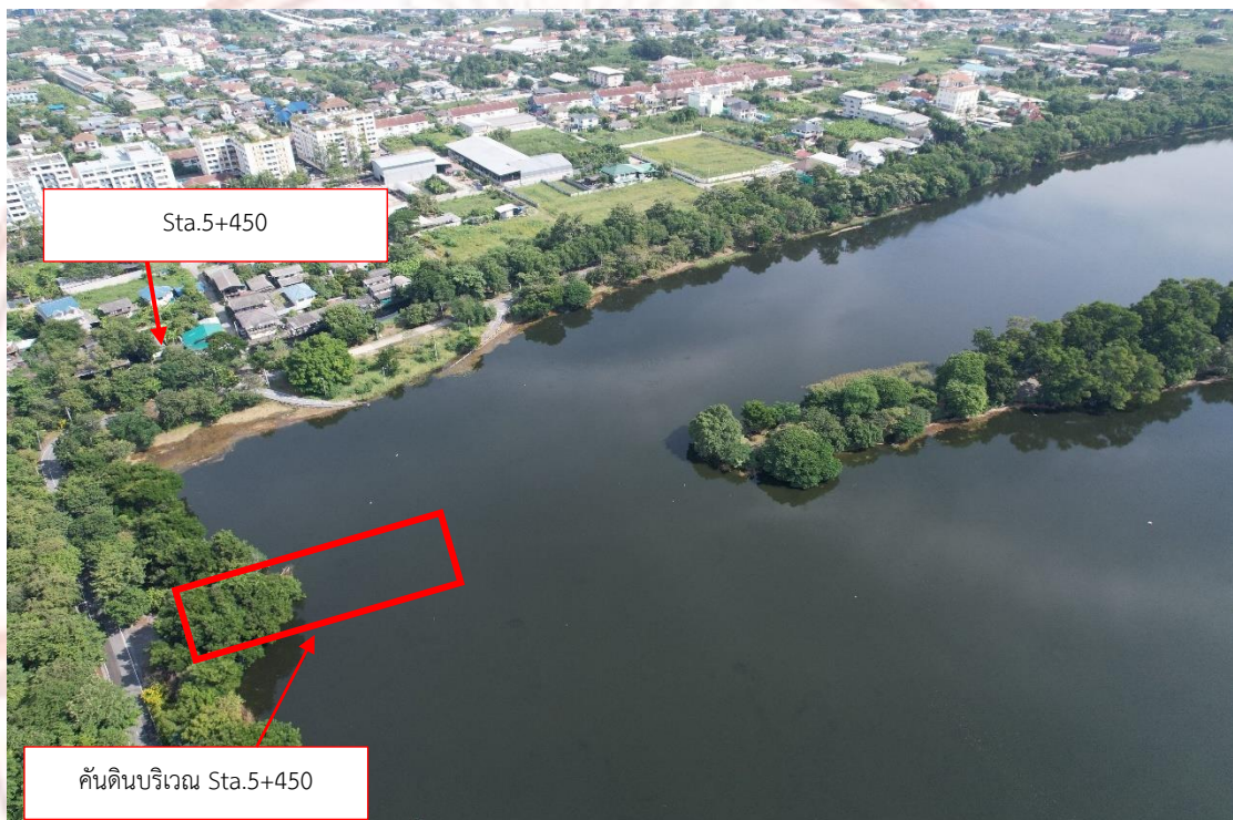
ภาพที่ 3-12 คันดินภายในบึงหนองบอนบริเวณ Sta.5+450
