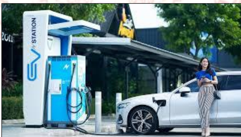
ภาพที่ 2-4 สถานีบริการชาร์จรถไฟฟ้า EV Charging Station
